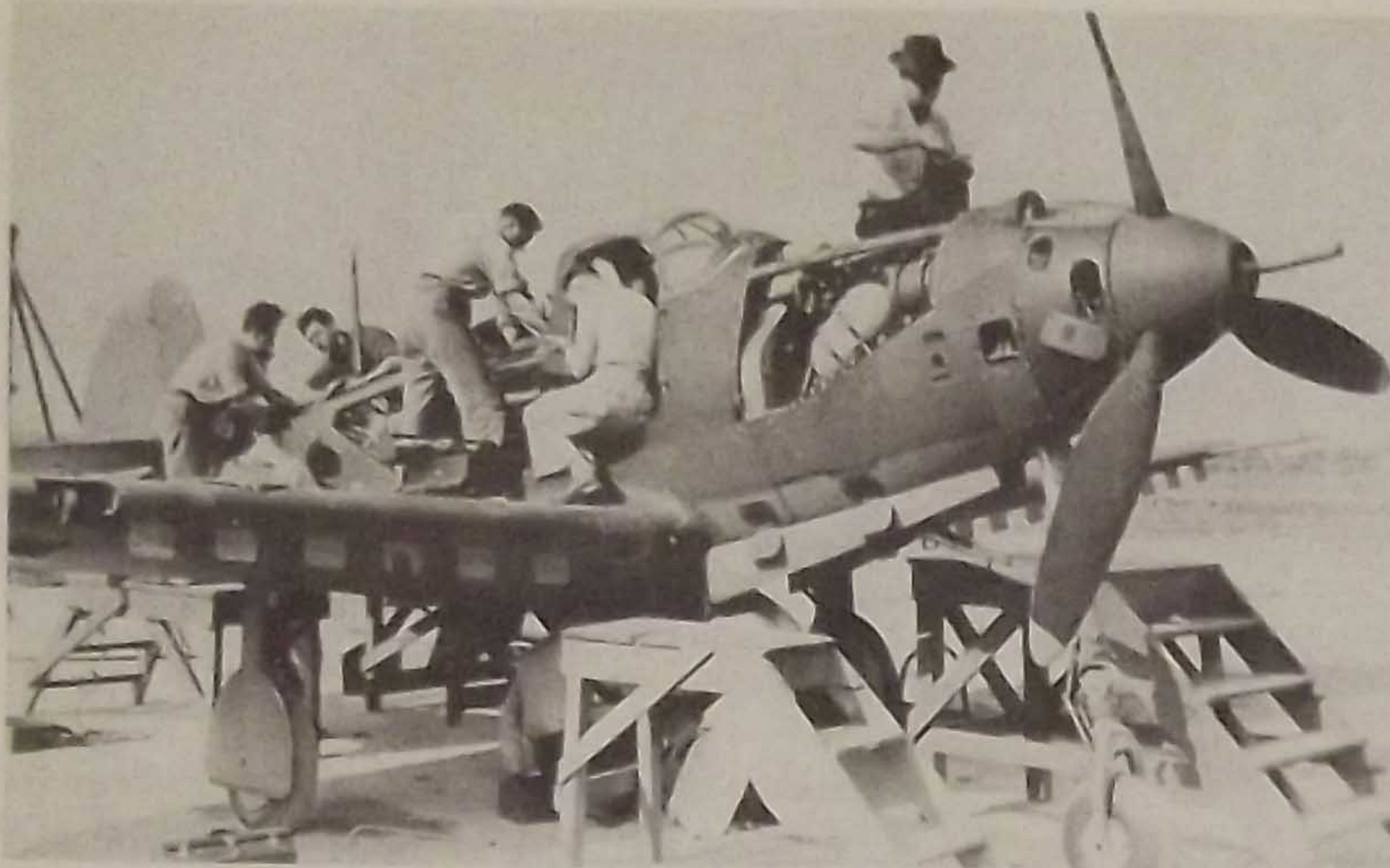
Р-39 (вариант с 20-мм пушкой) во время технического обслуживания. Обратите внимание на огромное количество эксплуатационных лючков
